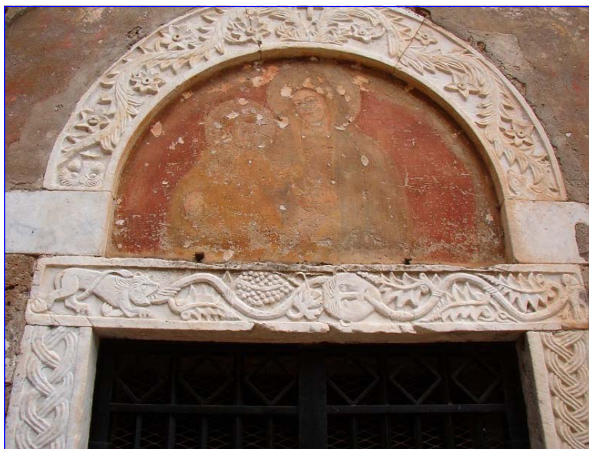
Lunetta del portale centrale
